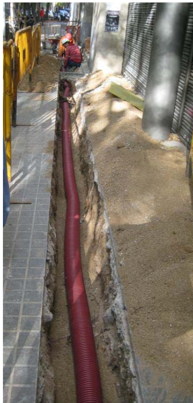
Vista des del sud de la col·locació del tub (079/12-007)
