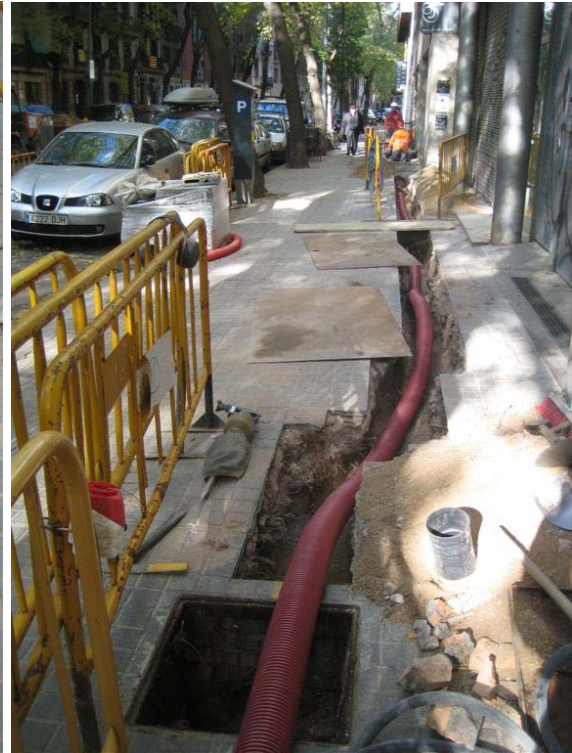
Col·locació del tub, extrem sud de la rasa (079/12-008)
